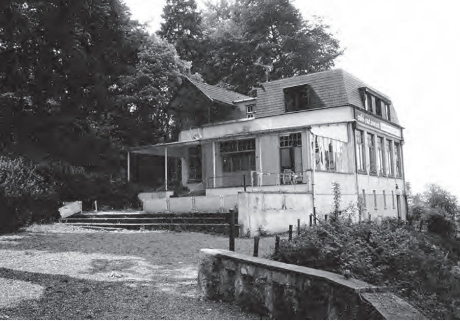
AFBEELDING 21: Restaurant “Het Rotspark” stond decennialang op instabiele mergelgangen. Niet lang na de ontdekking van “Groeve Westelijk van de Heksenkeuken” werd het gebouw gesloopt, waarbij nog meer onbekende gangen onder het hotel bloot kwamen te liggen ( Foto: Jacquo Silvertant 1989).
